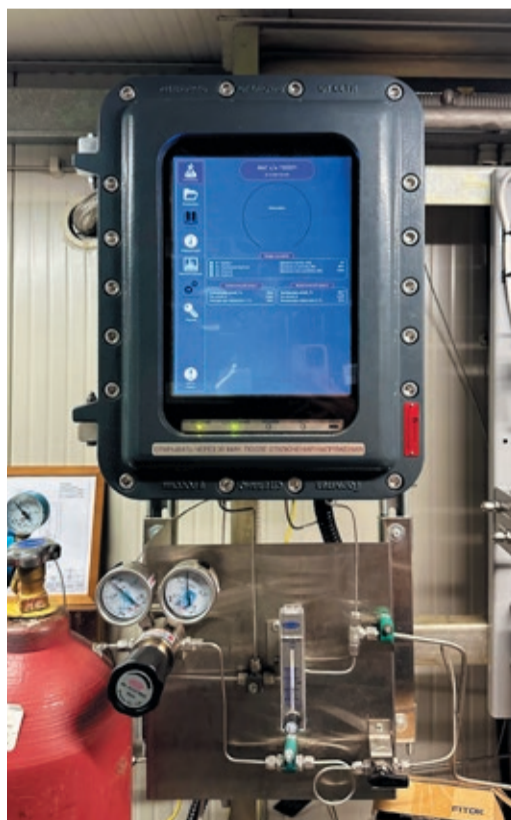
Метрологи отмечают удобную систему управления хроматографом
