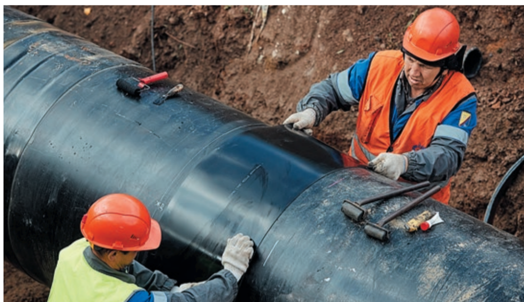
Первая нитка магистрали «Бухара — Урал»: прежде чем ремонтники УАВР № 1 приступили к работе, газ из участка сработали на потребителей
