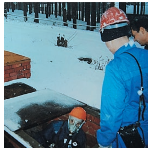
Первая практика машинистов ТК проходила в канализационном колодце базы отдыха Черданцево (2002 г.)
