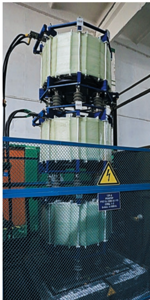
Реакторы обеспечивают плавный пуск ЭГПА и берегут ресурс двигателя
