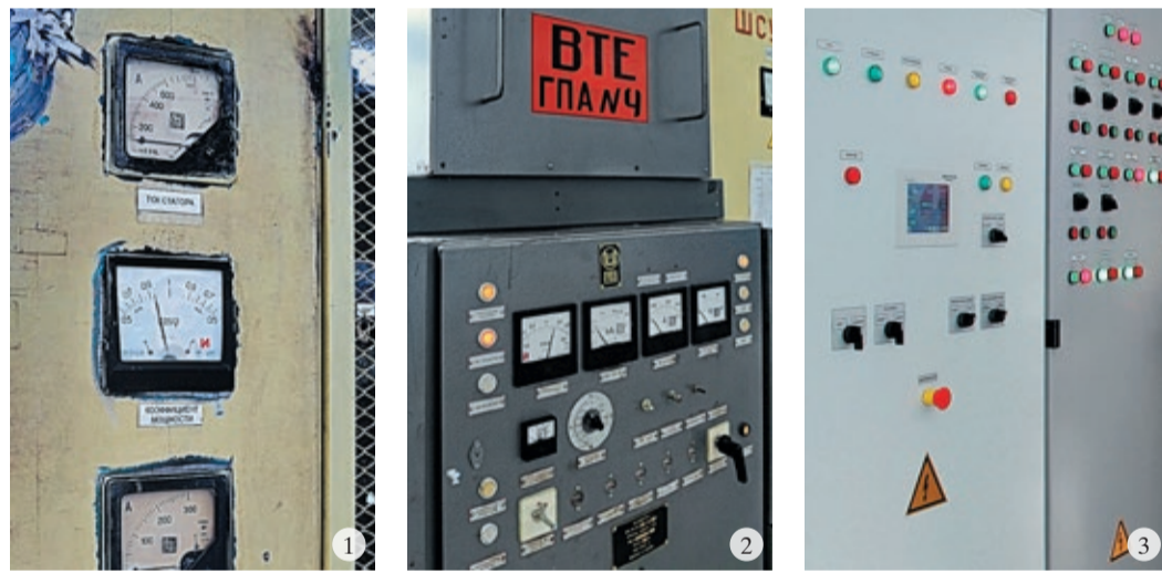
В 2023 году в машинном зале КС-17 электрохимические возбудители образца 1963 года (фото 1) и экспериментальные тиристорные возбудители 2000-х годов (фото 2) окончательно сменила современная автоматика (фото 3)
