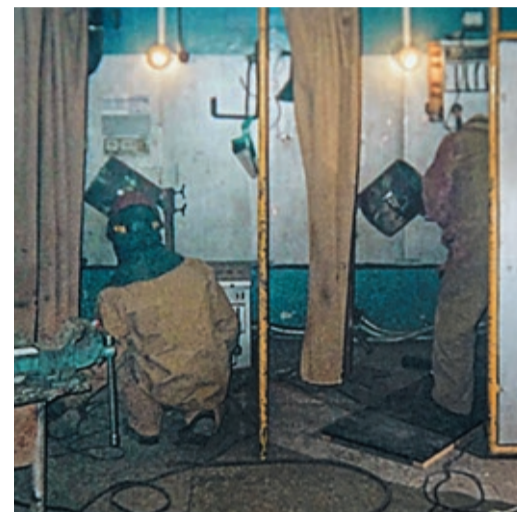
На протяжении долгих лет сварщики соревновались на площадке Малоистокского ЛПУМГ
